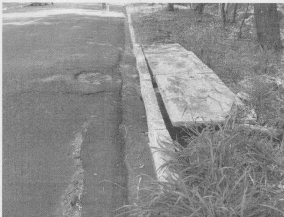
FIGURA 5 – Bueiro aberto devido a erosão
