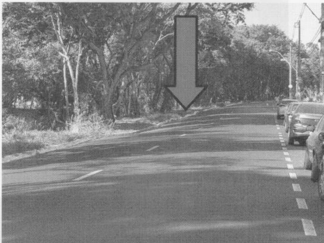
FIGURA 1 – Asfalto cedendo e ausência de calçada
