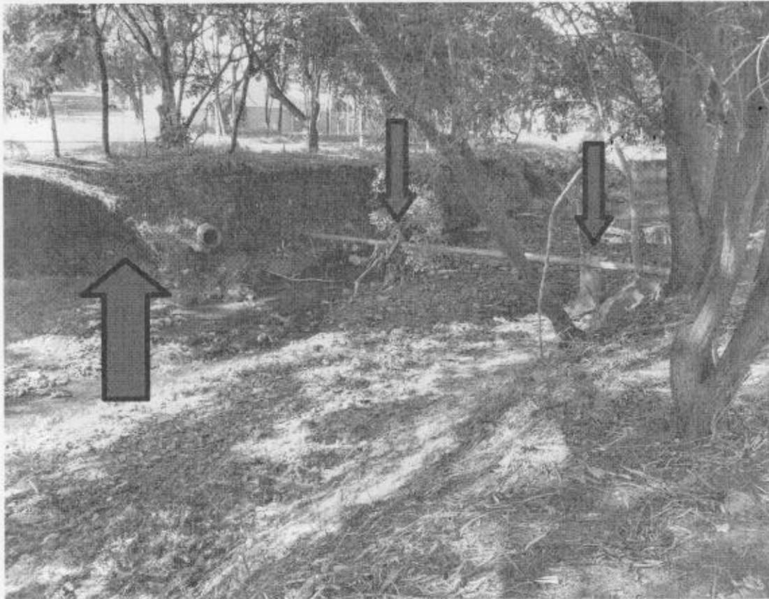
FIGURA 7 – Lateral do córrego erodida e encanamento suspenso precariamente
