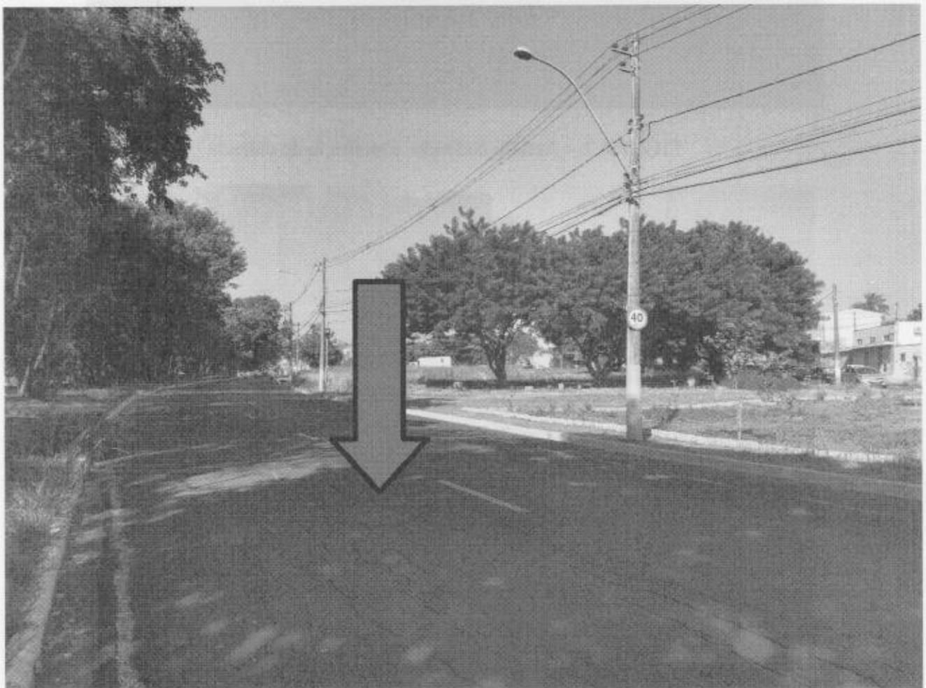
FIGURA 4 – Rachaduras no asfalto indicando a erosão para dentro do córrego e ausência de calçadas
