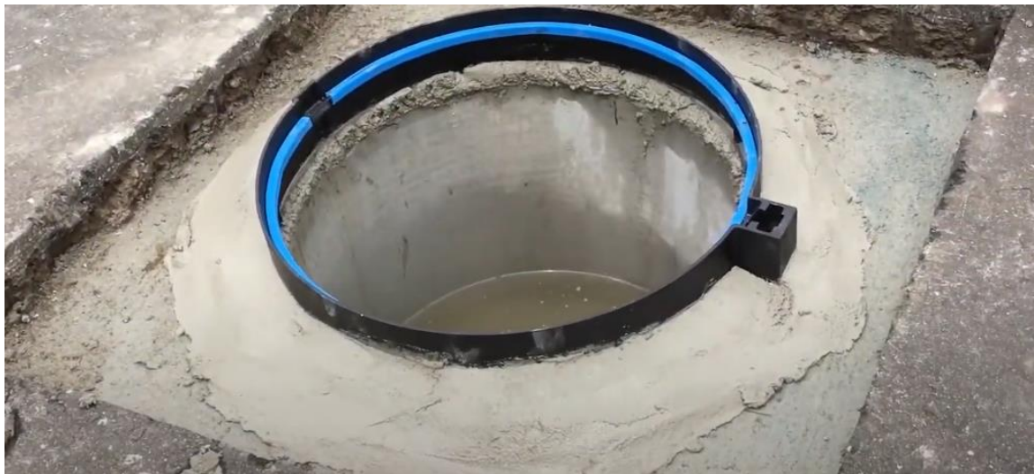
Figura 08: utilização de concreto para afixar tampão.
