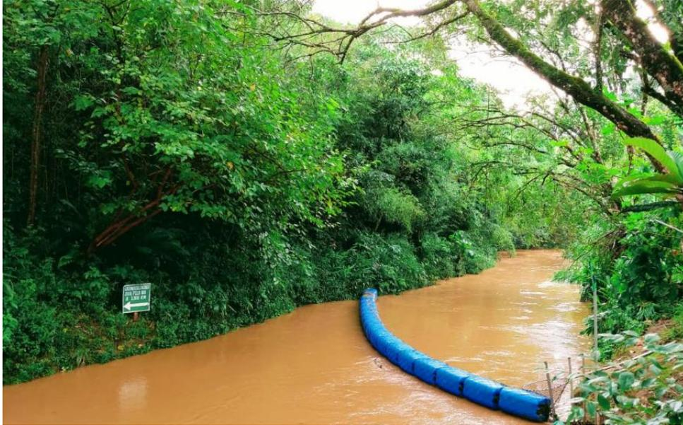
**Figura 1: estrutura deverá ser implantada de maneira diagonal para facilitar a coleta dos resíduos sólidos flutuantes que se depositam as margens e coletados com um puçá.**
