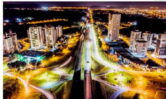
O projeto de Parceria Público-Privada visa o desenvolvimento, modernização, expansão, eficiência energética, operação e manutenção da rede municipal
