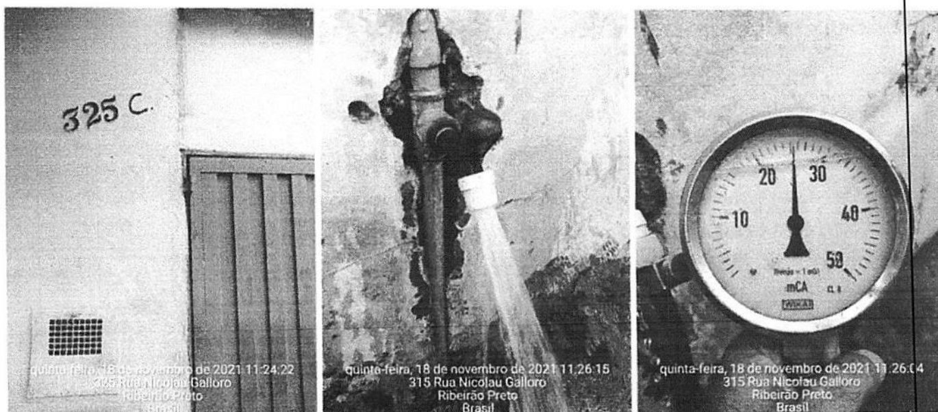
Figura 1 – Visita técnica em imóvel localizado na Rua Nicolau Galloro, 325, Jardim Pedra Branca, com aferição indicando 25 mca de pressão.
