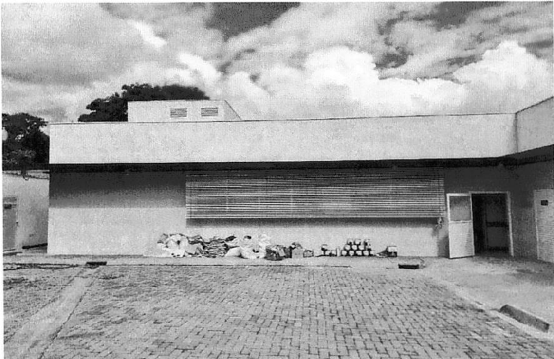
Clínica veterinária em fase final de obra
