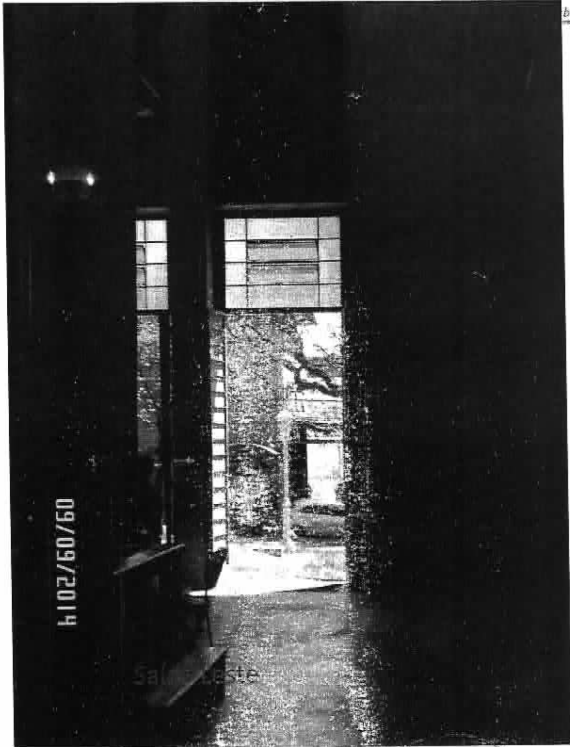
Figura 07 - Interior da Igreja saída leste.
