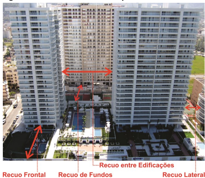
Figura 61: Demonstrativo esquemático de recuos
