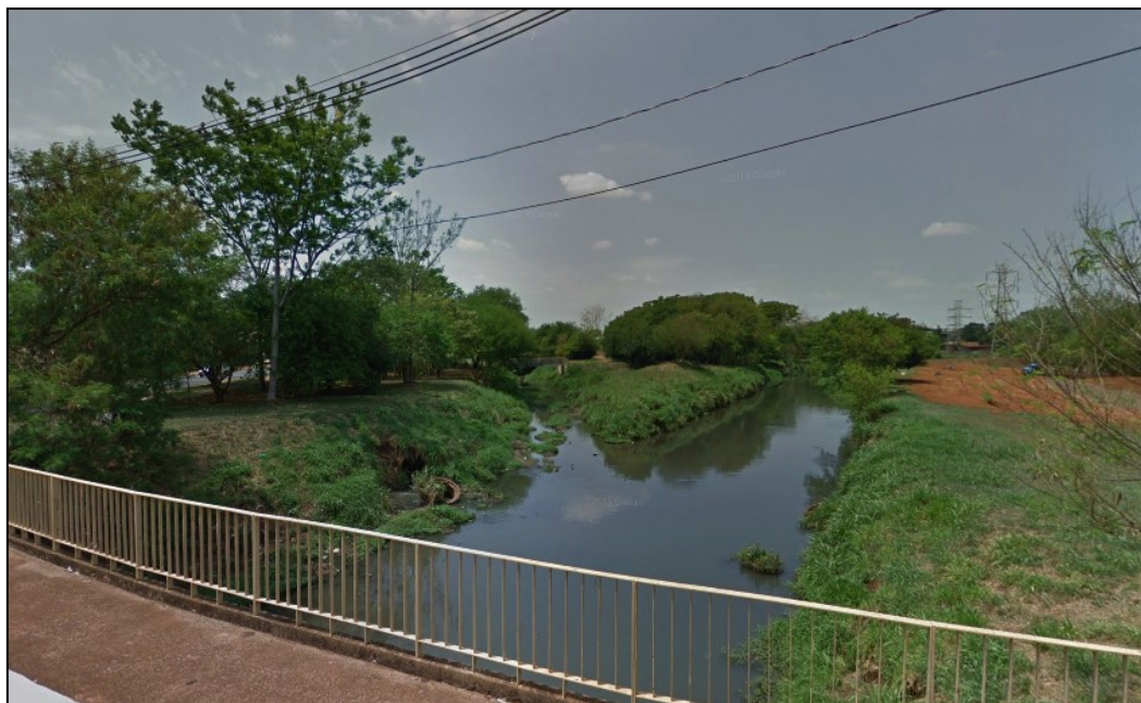
Figura 04: Detalhe de Trecho da Via Norte
