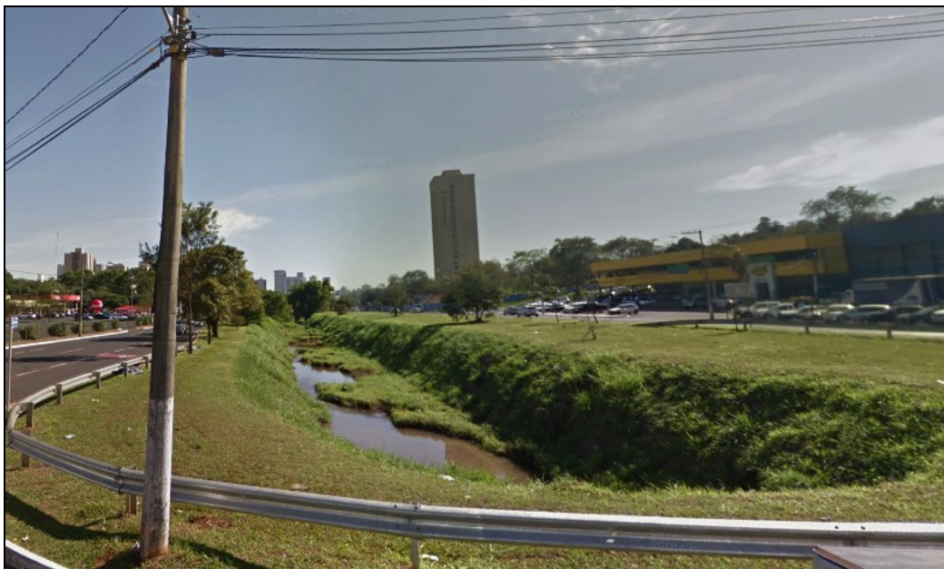
Imagem 7: Deposição de Material Vegetal de Rocadas no Córrego
